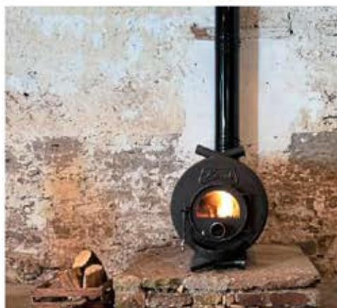
Ein freistehender Gussofen sorgt in der Kelter für Wärme im Winter. Archivfoto: privat
